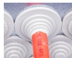
Abb. 2: Stufennippel mit Schutzart IP 55 am Kabeleingang
