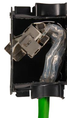
Abbildung 2: Buchse in flacher Schalterdose (Tiefe: 46 mm) inkl. rückwärtigen Schirmungsblech (Einbautiefe Buchse: 25,5 mm)
