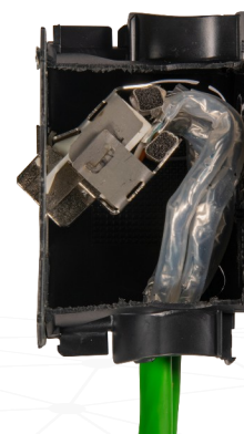
Buchse in flacher Schalterdose (Tiefe: 46 mm) inkl. rückwärtigen Schirmungsblech (Einbautiefe Buchse: 25,5 mm)
